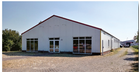
Veranstaltungshalle in Hesel, An der Fabrik 15
