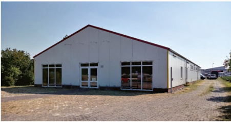
Veranstaltungshalle in Hesel, An der Fabrik 15
